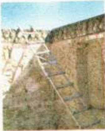
شکل 4.31: دیوار کی جانب جھکی ہوئی سیڑھی
